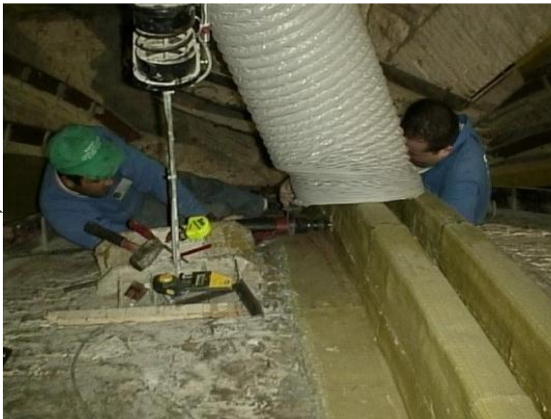
Apposition à l'extrados de nervures de renforcement (bois et composites)
