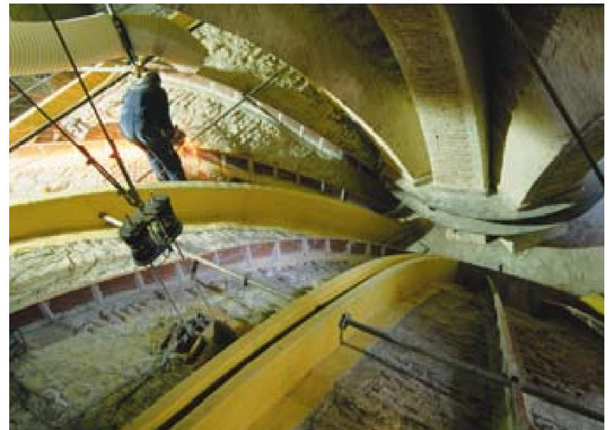
Connexion des voûtes au toit, au moyen de câbles
